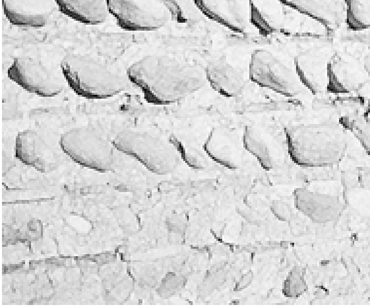
صورة 05 تقنية رصف الحجارة - منشأة مائية بوادي بسكرة -
