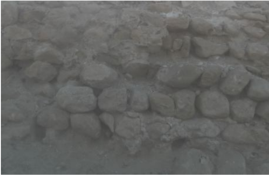
صورة 02 استخدام الحجارة الدبشية في قناة مبنية شمال تهودة عن الطالب
